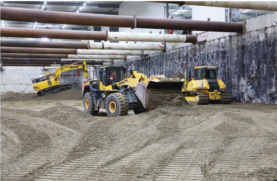
Schwere Baumaschinen sorgen für eine gleichmäßige und lagenweise Verteilung des eingebrachten Erdmaterials; Quelle: Pressefoto Roche.
