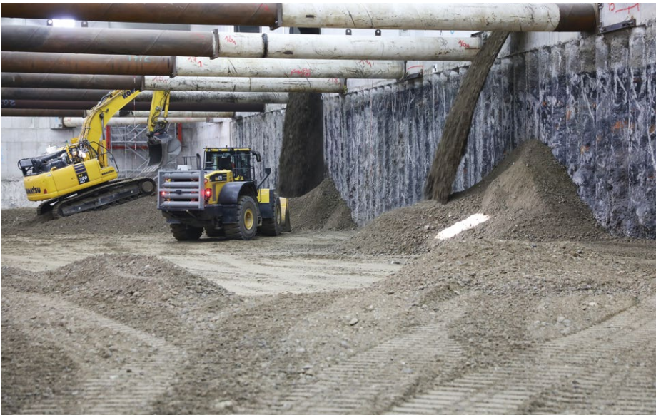
Sauberes Erdmaterial wird von einem LKW in das Baufeld Süd abgekippt; Quelle: Pressefoto Roche.
