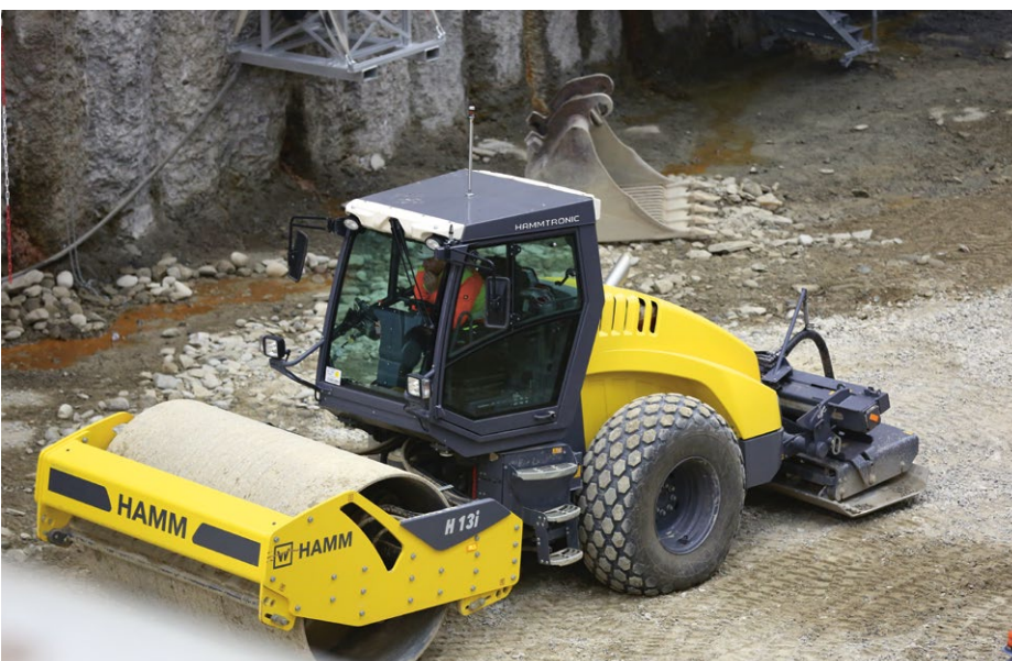
In einem weiteren Arbeitsschritt wird das Erdmaterial verdichtet; Quelle: Pressefoto Roche.
