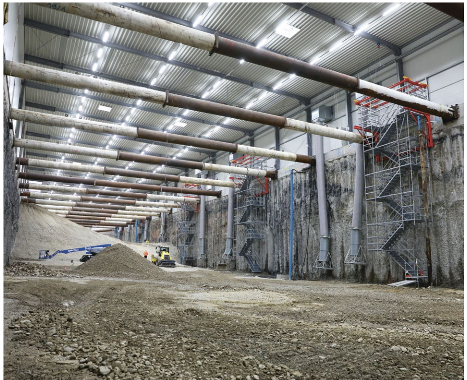
Blick in das Baufeld Süd kurz vor dem Beginn der Rückverfüllung; Quelle: Pressefoto Roche.
