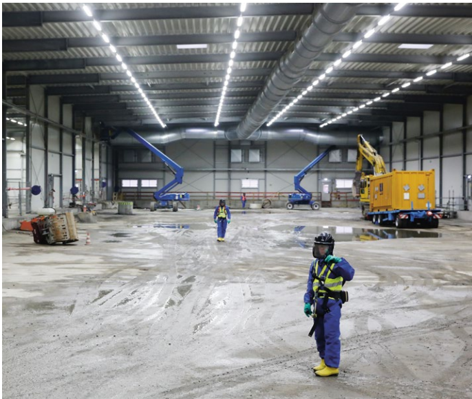
Blick in das Baufeld Mitte, nachdem die Elemente der Lagerboxen gründlich gereinigt und ausgeschleust wurden; Quelle: Pressefoto Roche.
