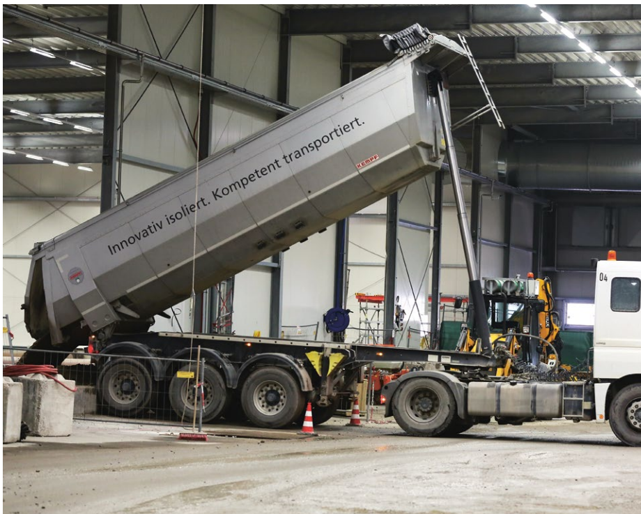
Sauberes Erdmaterial für die Rückverfüllung des Baufelds Süd wird von der Logistikhalle und vom Baufeld Mitte her eingebracht; Quelle: Pressefoto Roche.
