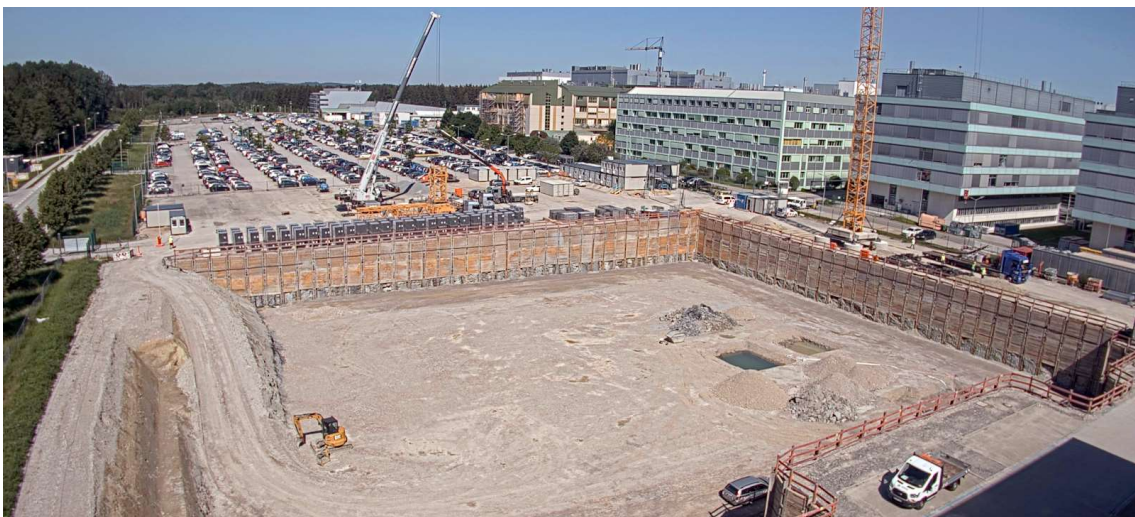
Aktueller Baufortschritt LEAP Gebäude (Stand 14.06.22)
